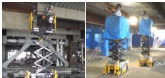
建トウンを用いた施工写真
